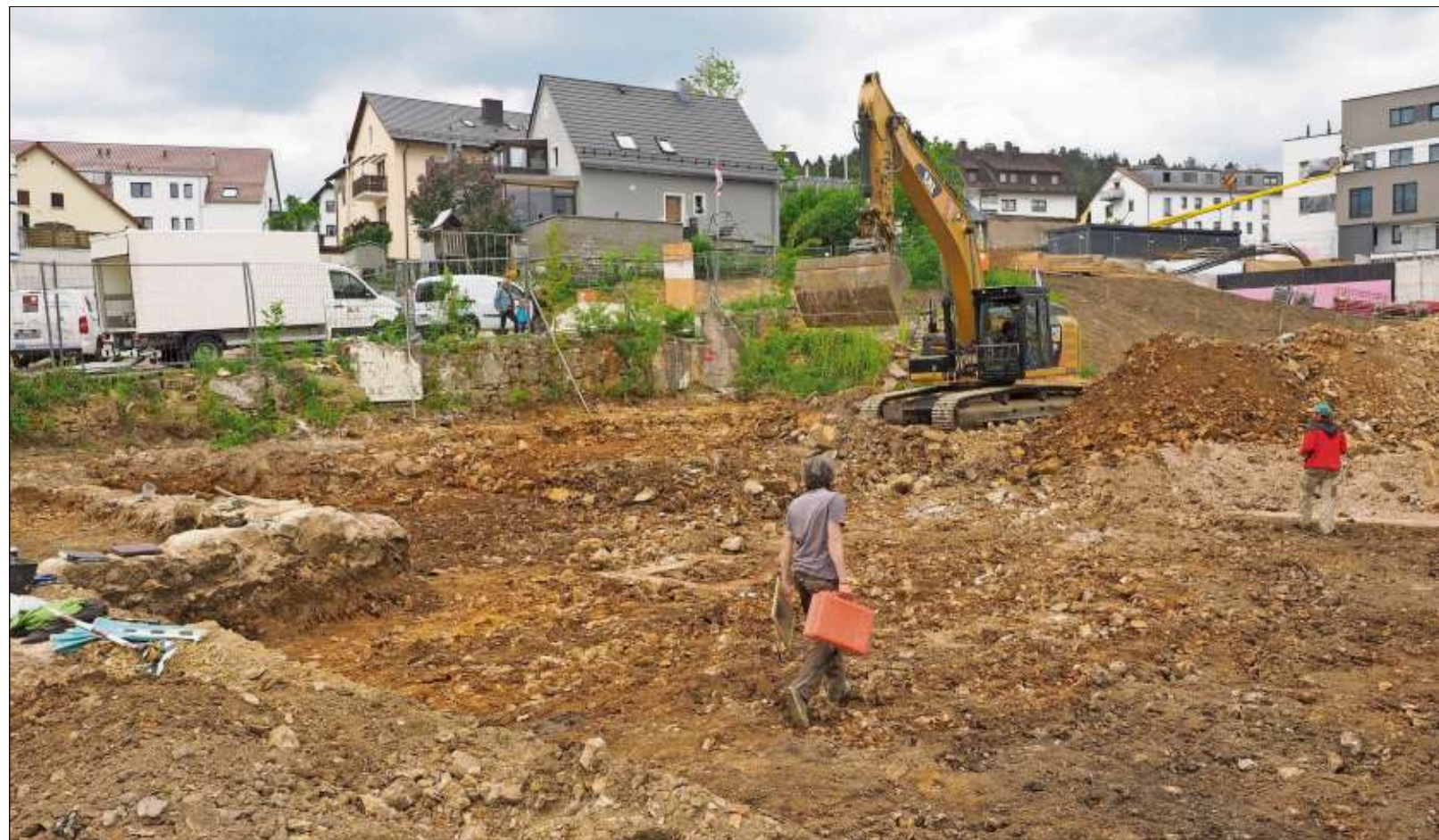
Seit einer Woche graben Spezialisten einer Bamberger Grabungsfirma auf dem ehemaligen PPP-Gelände, wo ein altes Kellergewölbe gefunden wurde. Dieter Hofmann von der Baufirma HD Bau hofft, dass sich dadurch nicht die Arbeiten am dritten Wohnblock verzögern. Foto: Klaus Trenz
