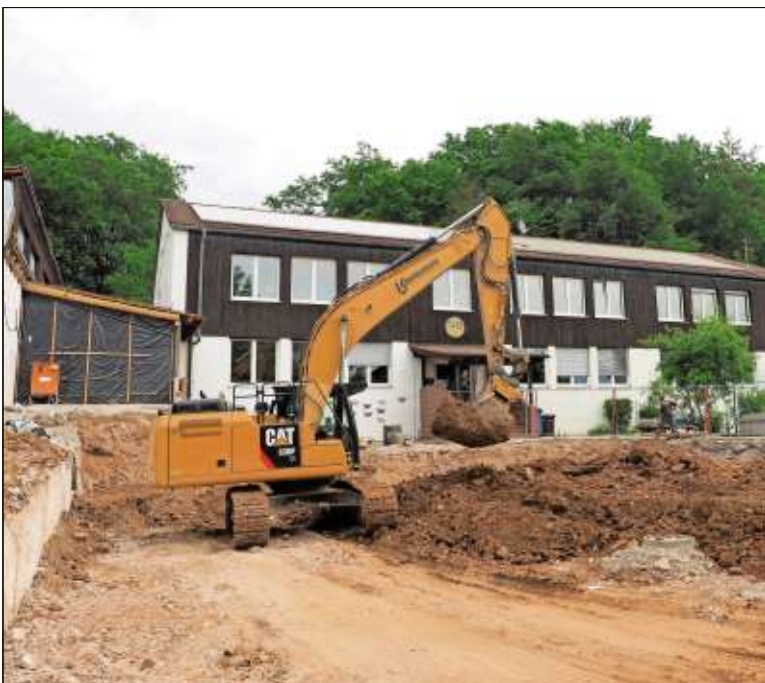
Nach dem Abriss der alten Turnhalle in Betzenstein haben in der vergangenen Woche die Arbeiten mit schwerem Gerät für den Bau der neuen Turnhalle begonnen. Foto: Klaus Trenz
